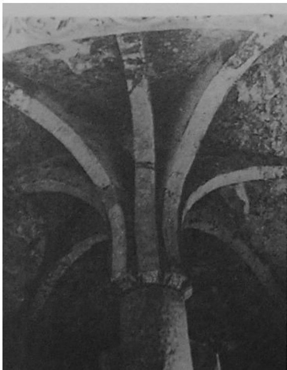
La columna central del templo mozárabe de San Baudilio de Berlanga. Entre las nervaduras se distinguen los agujeros por los que se entra en el cubículo de la cima del templo.
